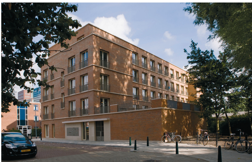
de kopgevel met hoofdentree en toegang tot de fietsenstalling
