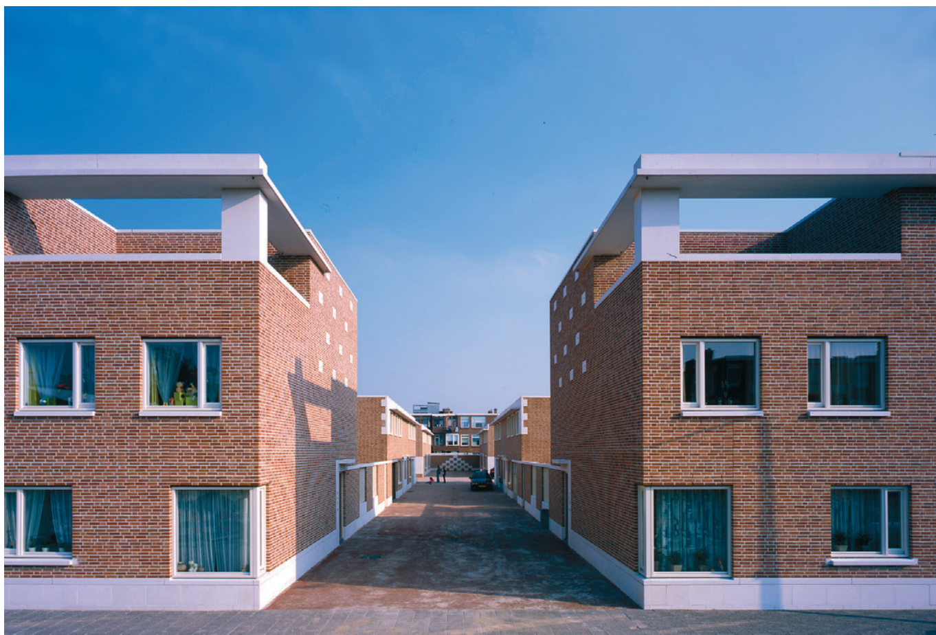
eengezinswoningen met terras op de 3e verdieping
